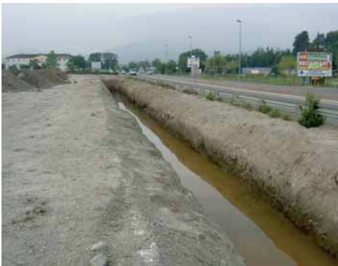
Excavation avant mise en place du geotextile
