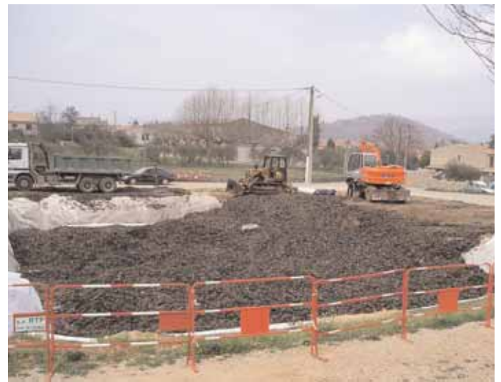
Remplissage en Draingom sur nappe de géotextile
