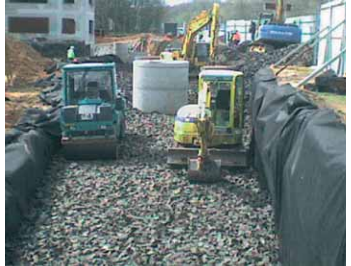
Compactage par couches de 30 cm
