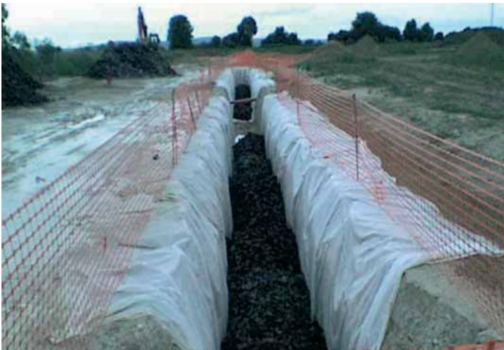
En cours de remplissage
