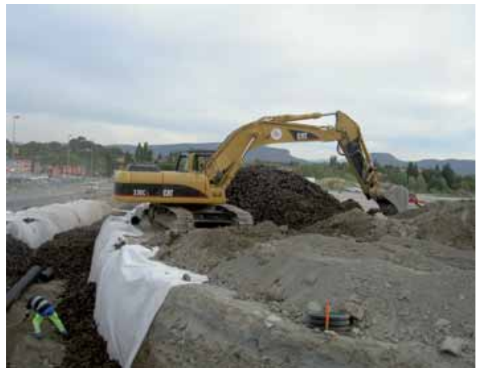
Remplissage en Draingom
