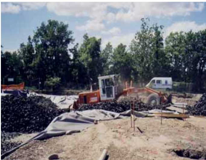
Réglage à la niveleuse
