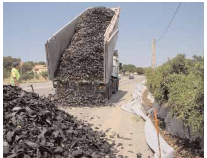
Déchargement du Draingom
