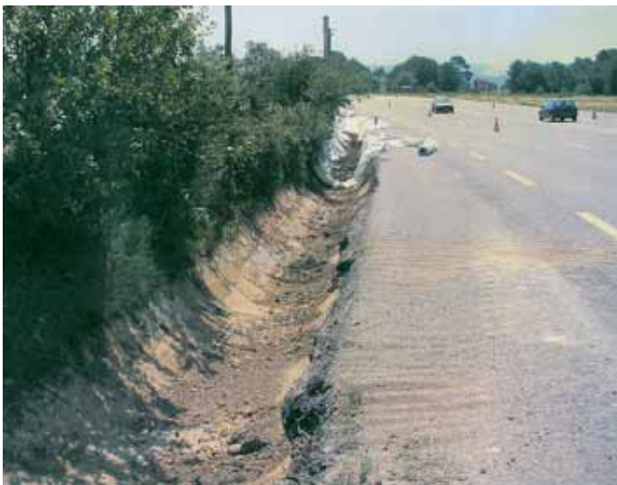
Fossé calibré avant pose du géotextile
