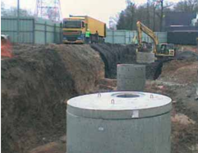
Le terrassement terminé avant pose du géotextile
