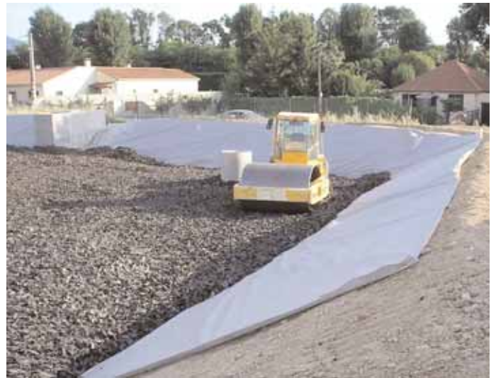
Compactage au rouleau vibrant
