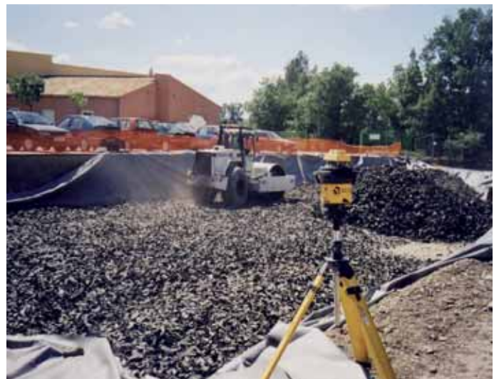
Compactage au rouleau vibrant
