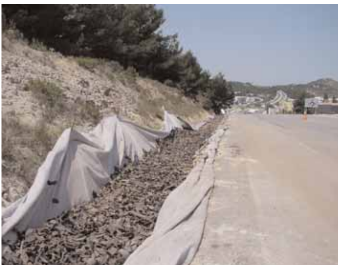
Remplissage du fossé en DRAINCOM
