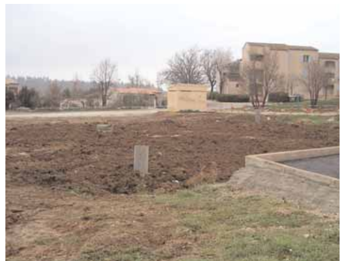
40 cm de terre végétale permettent de créer un espace vert et un terrain de jeu pour l'école
