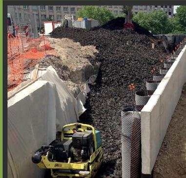
Stabilisation des remblais périphériques et drainage en pied de murs.
