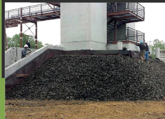
Application en remblai technique permettant la stabilité de l'ouvrage sur des terrains compressibles.
