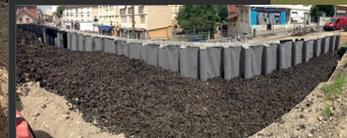
Remblai technique de renforcement et de protection autour d'un bâtiment.
